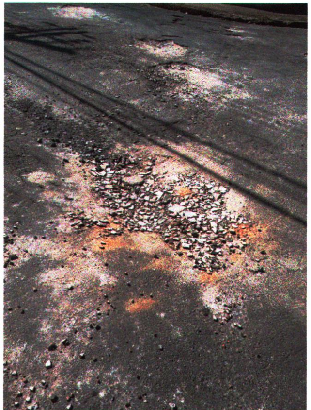
Recapeamento/operação tapa-buraco (RCK)
